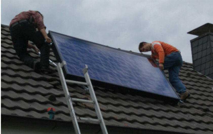
Bild Gerenda Solarthermie Montage
